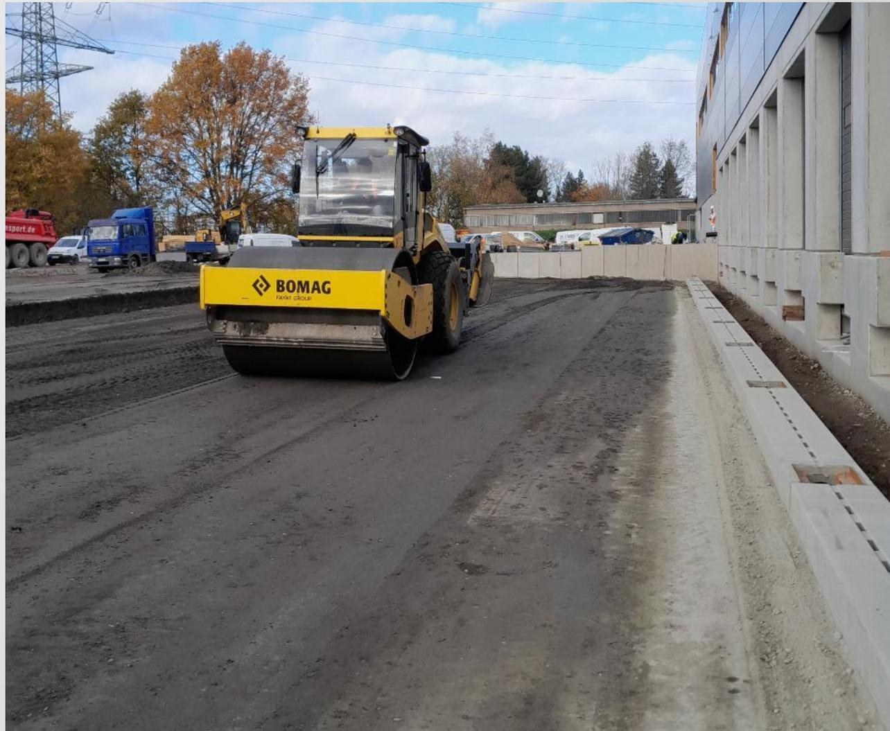
**Fertig hergestellte hydraulisch gebundene Tragschicht in-situ**
