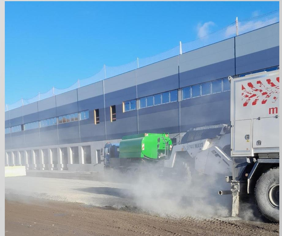
**Einfräsen der genau definierten Menge (kg) NovoCrete® ST 98 pro Quadratmeter (m<sup>2</sup>)**
